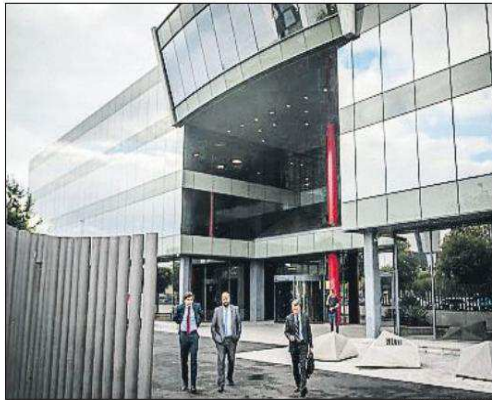
El Centre de Telecomunicacions lidera diversos projectes 5G
